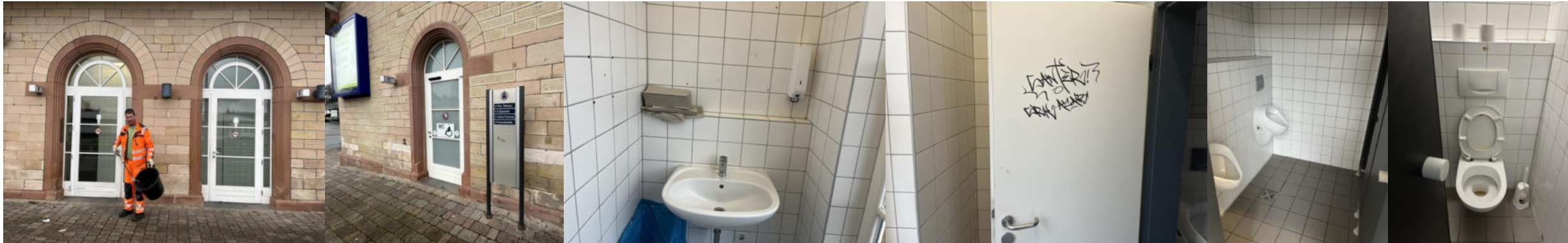
Weniger angenehmes Bild in den öffentlichen Toiletten im Bahnhof Michelstadt
