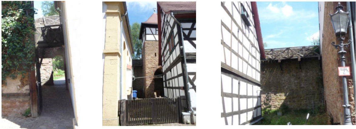
Abbildung 42: Zugänge und Durchblicke zur Stadtmauer
