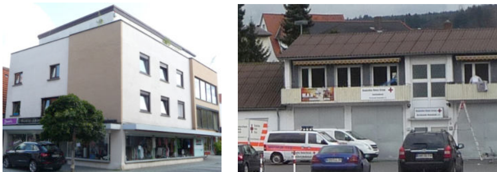
Abbildung 43: das Stadtbild negativ prägende Gebäude
